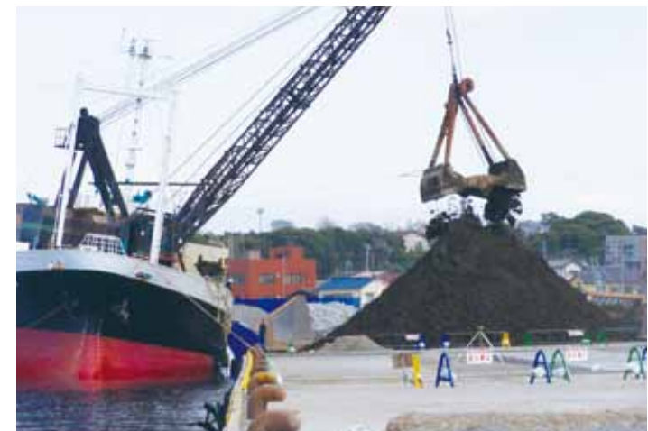
港での残土積みおろし作業
