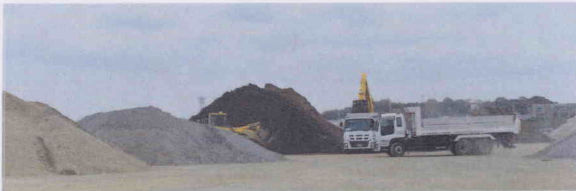
写真-2 館山港での残土仮置き場（積み出し地点）
