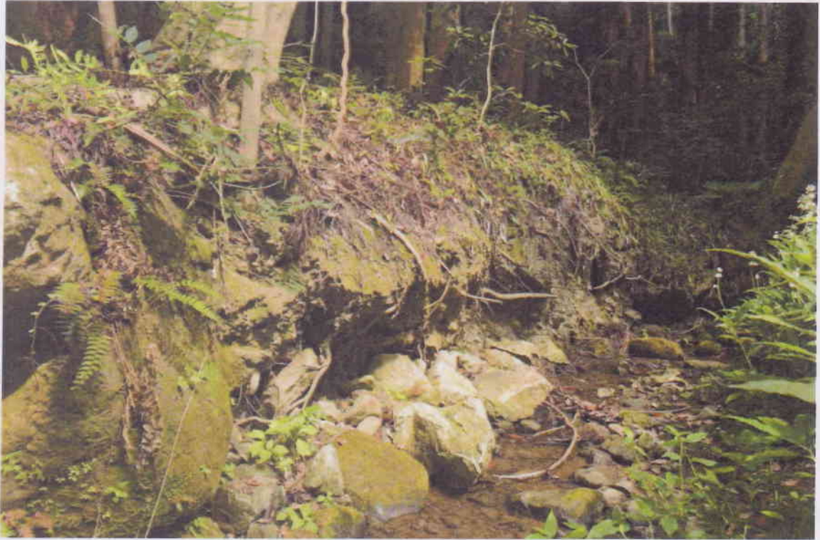
写真-5 溪流の攻撃斜面が大きくえぐられている。下部の礫は古い土石流、それを覆う新しい土石流堆積物
